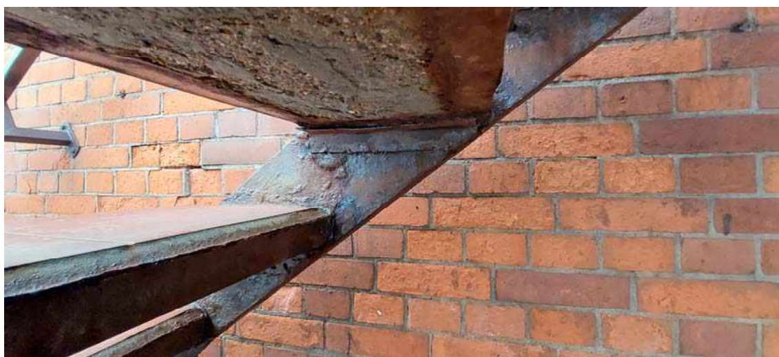
Rys. 2 Widok skorodowanych elementów biegu schodów przy drzwiach D1.
