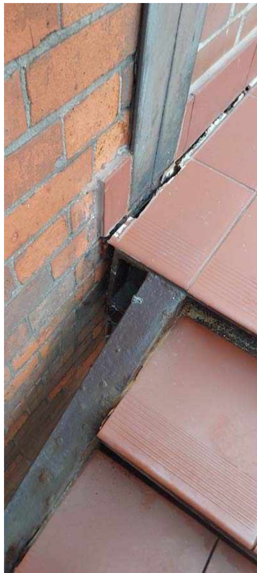
Rys. 6 Widok oparcia belki policzkowej.
