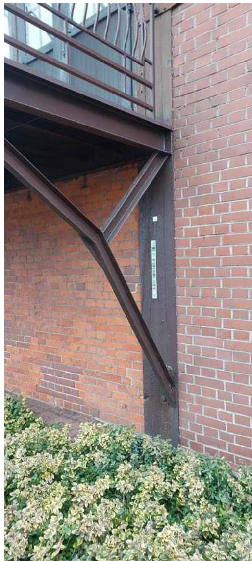
Rys. 4 Widok oparcia spocznika na ścianie schodów przy drzwiach D1.
