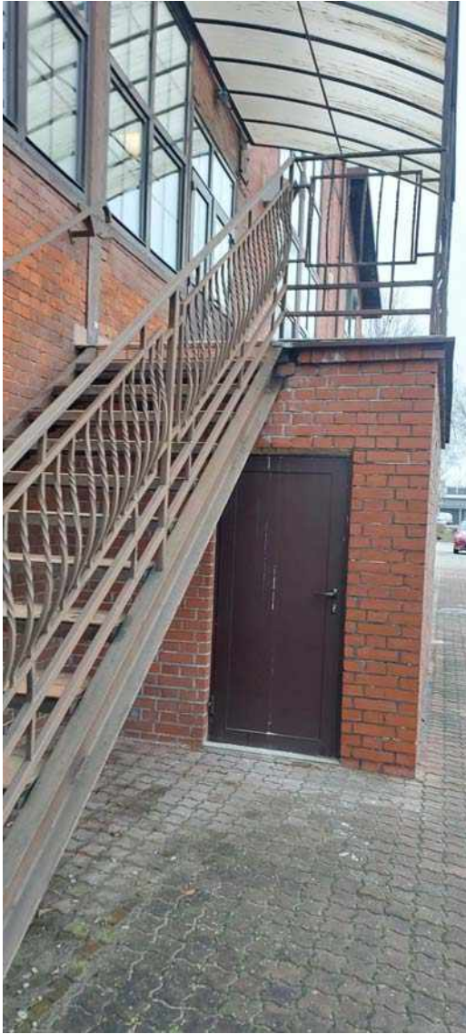
Rys. 7 Widok biegu, spocznika i zabudowy pod spocznikiem schodów przy drzwiach D2.
